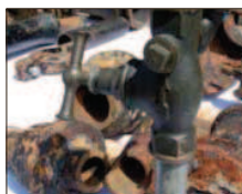
Sehr gut erhalten sind die 100 Jahre alten Gussrohre der Denzlinger Wasserleitung, wie sie im Unterdorf und in der Siedlung noch heute verlegt sind.
